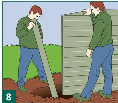
Passgenaues Einsetzen des zweiten Pfostens (Zwischenpfosten) für die Montage weiterer Betonplatten. Pfosten lotgenau ausrichten und einbetonieren. Auffüllen des Betons bis unter die Platten zur zusätzlichen Unterstützung.
