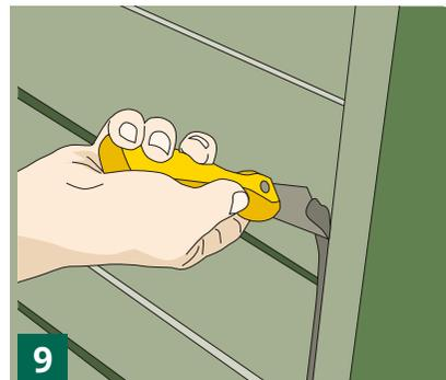
Für ein einheitliches Bild Ausrichten der Platten mit einem Hebel. Ausbessern und Verspachteln kleinerer Abbrüche oder Haarrisse mittels Spachtelmasse. Verfüllen und Glätten der Fugen mit Fugenmörtel.
