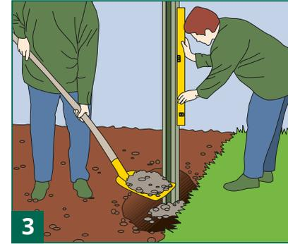
Montieren der Betonelemente erfolgt immer waagrecht. Einbetonieren des Anfangspfostens mit Kies, Sand-Zement-Gemisch – Betongüte C16/20 – erdfeucht. Lotgenaues Ausrichten des Pfostens beachten.
