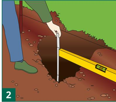
Erstellung von Punktfundamenten für die Pfosten. Ausheben des ersten Erdloches für den Anfangspfosten (L 80/B40/T90 cm).
